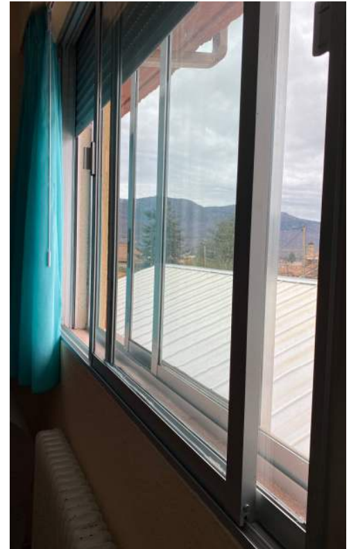
VENTANAS DE AULAS
