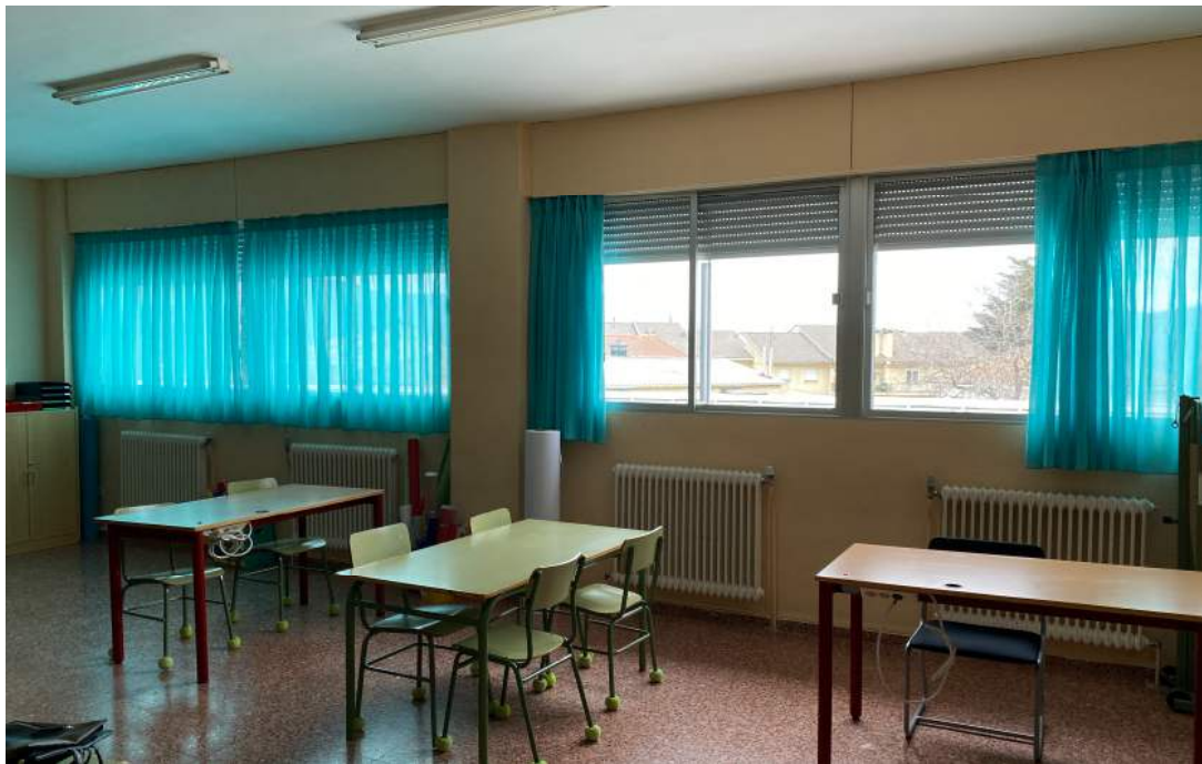
VENTANAS DE AULAS
